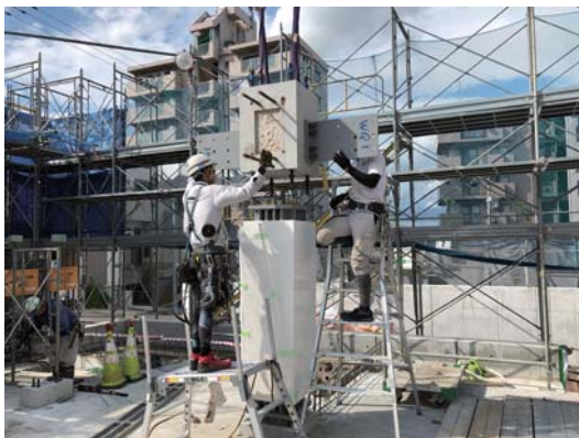
写真-24 仕口部PCaの建て方
