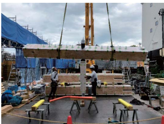
写真-25 間柱・梁地組状況
