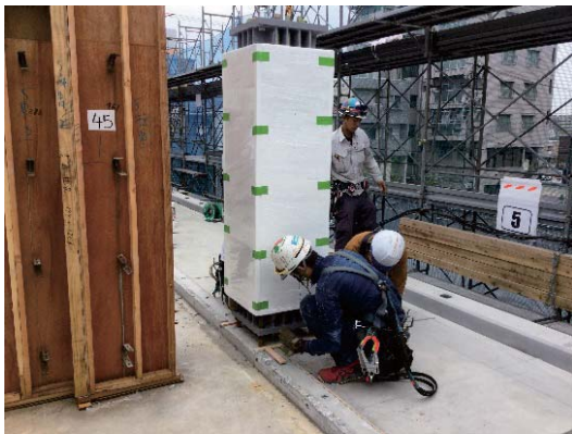
写真-22 スリム耐火ウッド®柱脚部施工状況
