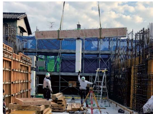
写真-26 スリム耐火ウッド®梁の建て方
