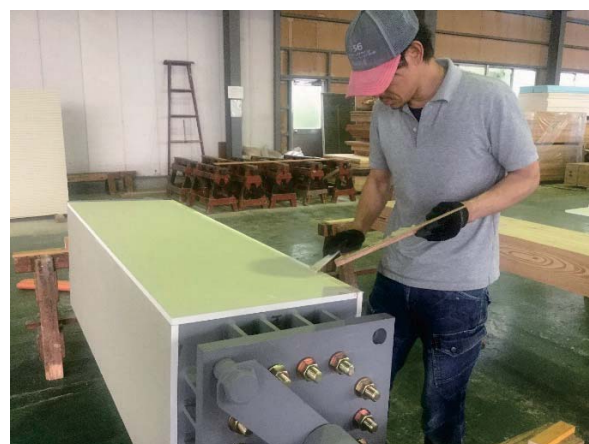
写真-16 スリム耐火ウッド®柱部材製作状況
