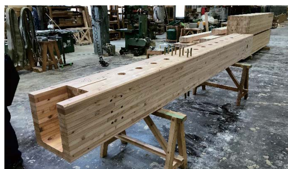
写真-15 スリム耐火ウッド®柱部材製作過程
