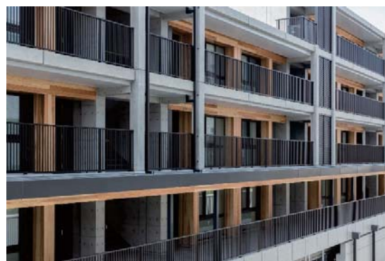
写真-7 北側（共用廊下側）外観
