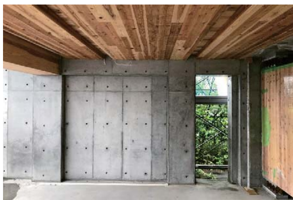
写真-20 RC-CLT合成床版のモックアップ
