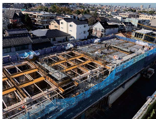
写真-21 施工状況 全景
