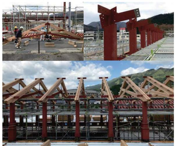
写真-5 施工中の合成トラス
