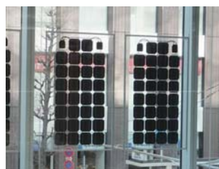
写真-7 室内吊下げ式PV 23)
