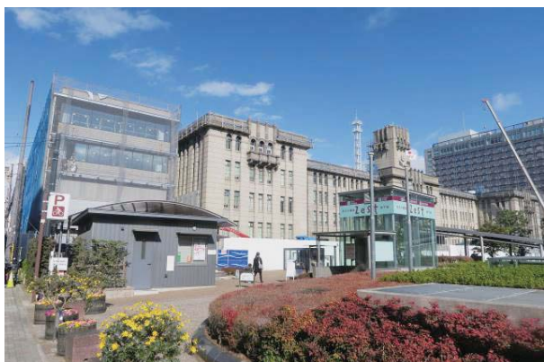
写真-2 敷地南西より建設中の西庁舎・本庁舎を望む
