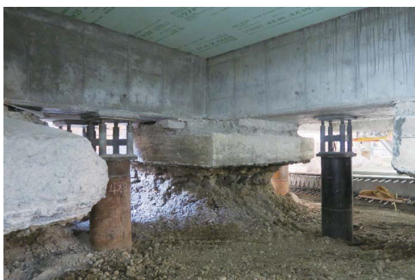
写真-3 仮設鋼管杭圧入完了時点
