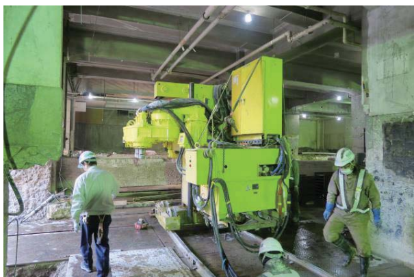
写真-5 既存建物下での SMW 施工
