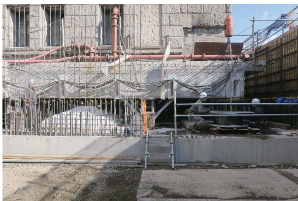
写真-4 免震装置据付
