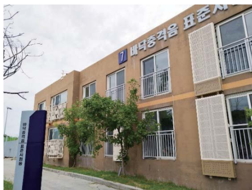
写真-13 床衝撃音試験用の実大実験棟（KICT）
