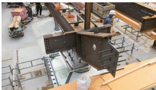
写真-6 1階SRC梁施工写真
