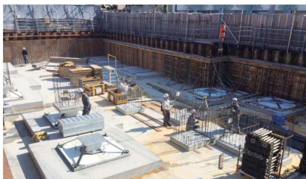
写真-4 免震材料施工写真1
