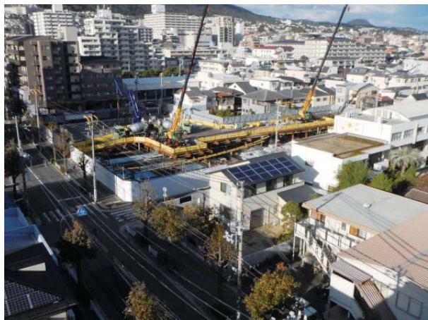
写真-3 全景施工写真
