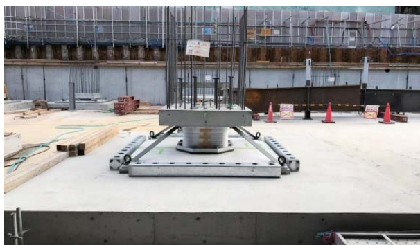
写真-5 免震材料施工写真2
