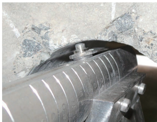
写真-5 孔内局部載荷状況
