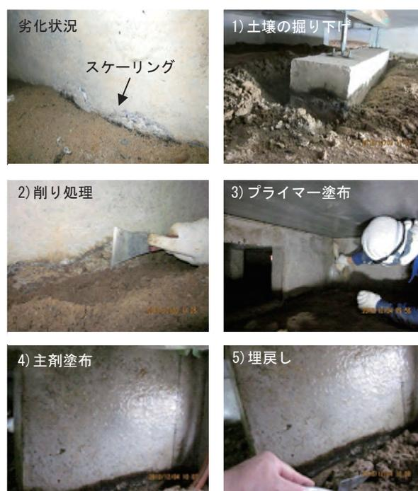
写真-7 コーティング材の施工手順
