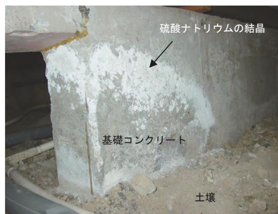
写真-1 住宅基礎コンクリートの劣化状況の一例
