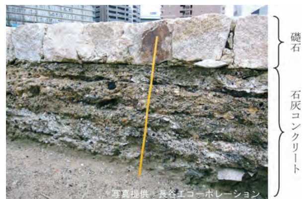
写真-4 石灰コンクリートの施工状況
