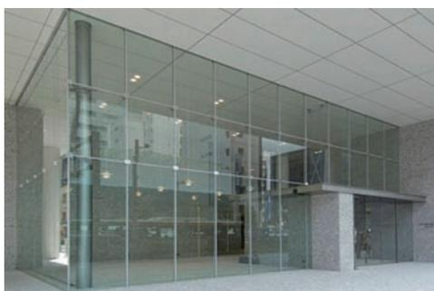
写真-15 MJG構法<sup>6)</sup>+ケーブルグリッド施工例外観
