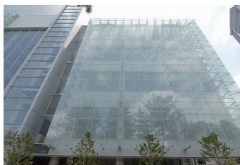
写真-17 MJG構法<sup>6)</sup>とストラット+タイイングロッド構造施工例外観
