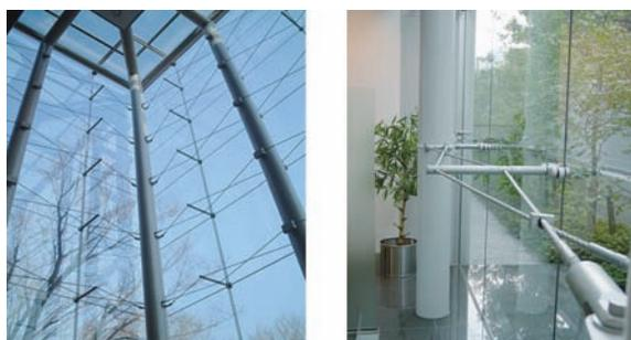
写真-13 テンショントラス施工例
