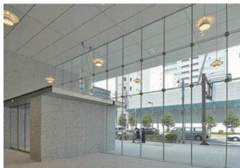
写真-16 MJG構法<sup>6)</sup>+ケーブルグリッド施工例内観
