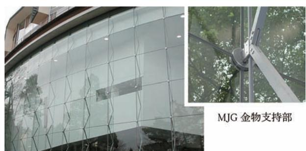
写真-14 MJG構法<sup>6)</sup>とテンセグリットトラス<sup>16)</sup> 施工例
