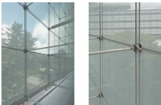
写真-18 MJG構法<sup>6)</sup>とストラット+タイングロッド構造施工例内観
