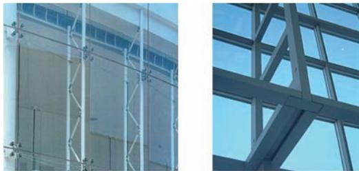
写真-12 トラス・ファイレンディールトラス施工例
