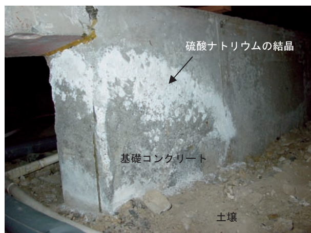
写真-1 住宅基礎コンクリートの劣化状況の一例
