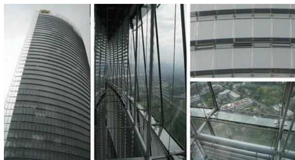
写真-19 複数階吹き抜け型キャビティ
