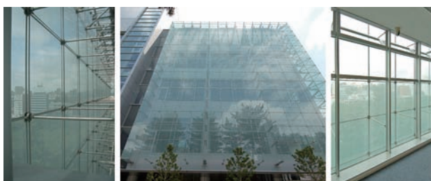
写真-17 最下階開放給気、最上階排気によるキャビティ
