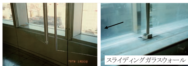
写真-15 エアフローウィンドウにおける内窓の開閉例
