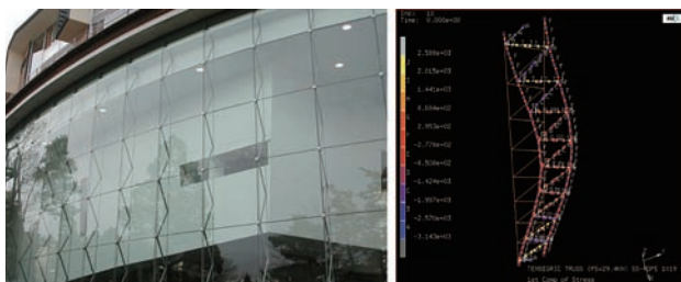
写真-35 テンセグリティトラス 図-21 テンセグリティトラス解析例
