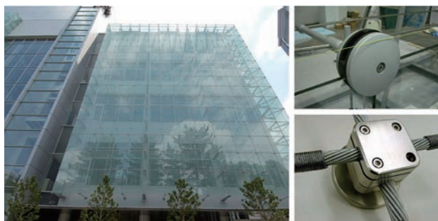
写真-29 適用事例と支持金物部分
