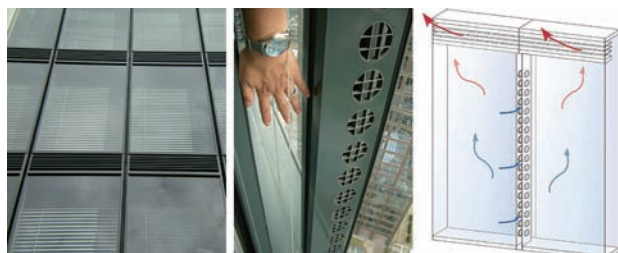
写真-21 縦型吸気上部排熱例
