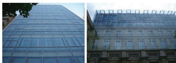
写真-16 完全密閉型吹き抜けキャビティ
