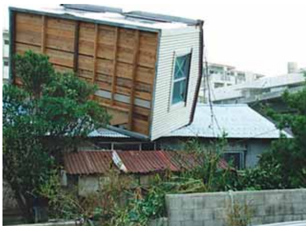
写真-3 プレハブ建物の被害 (石垣市提供)
