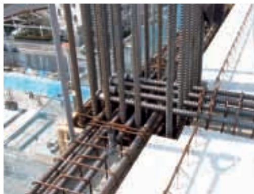
写真-1 機械式定着工法による配筋施工例
