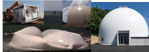
写真-1 RC シェルドーム工法
