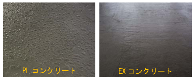
写真1 ブリーディングの抑制状況
