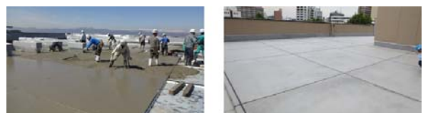
写真3 防水層押さえコンクリート施工状況
