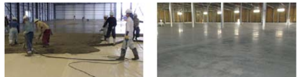
写真2 土間床施工状況
