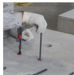
図-3 アンカー筋挿入
