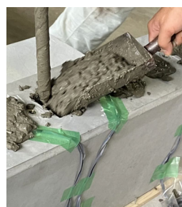
図-4 コンクリート打設
