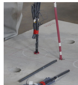
図-2 樹脂の注入
