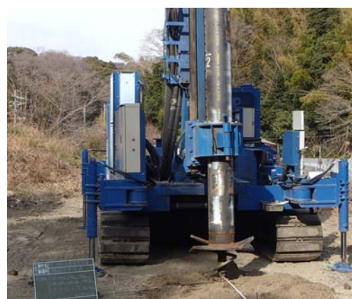
写真1 杭の施工状況
