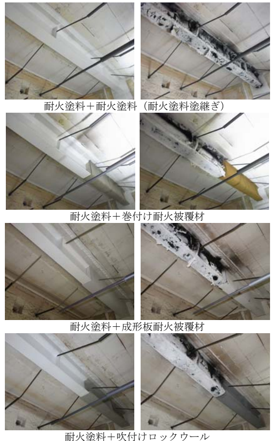
図 1 耐火試験前(左)・後(右)の梁試験体
