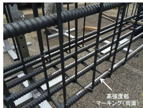
写真1 ダブルスタークの配筋例
