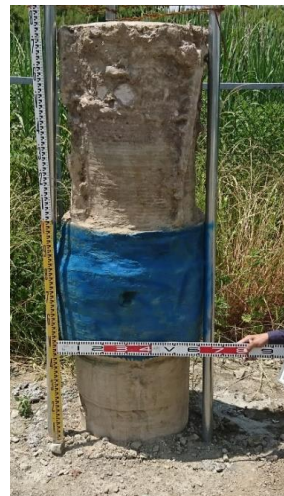
写真2 築造した改良体の一例 (着色部が拡径部)
