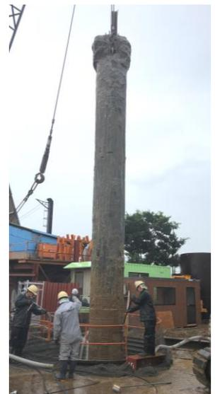
写真3 施工試験杭の掘出し状況
