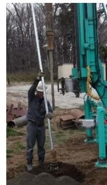
図4 細径鋼管の挿入状況
