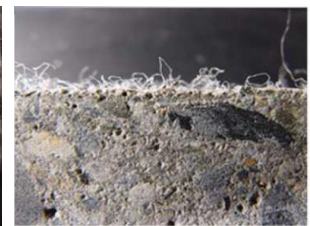
写真-2 タイル張り前のコンクリート断面例
