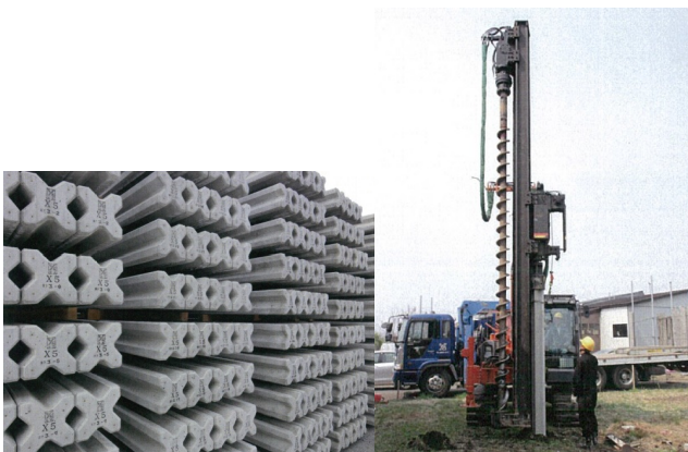
写真-1 補強材および施工状況
