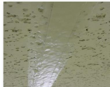
写真1 繊維補強塗料による塗膜
