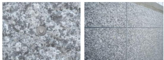
写真2 シート材およびアンカーピン
