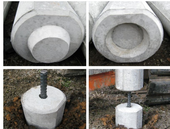
写真-1 補強材および施工状況
