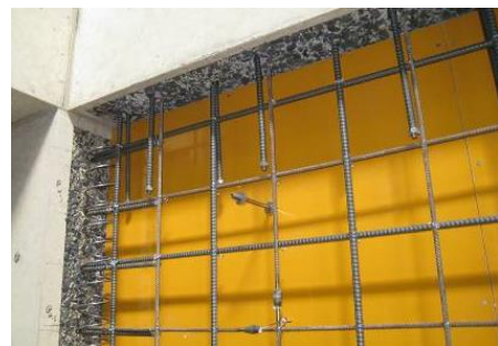
図3 WJ目粗し接合工法を併用した耐力の向上
