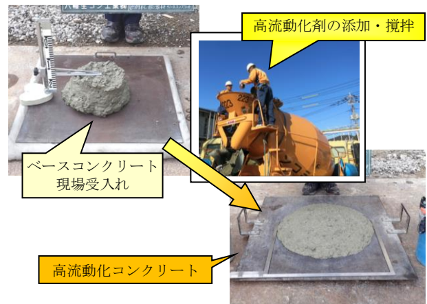
写真 現場添加型高流動化コンクリートの製造
