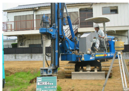
写真-1 施工状況
