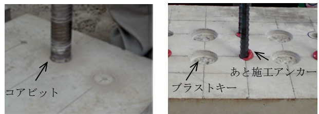
(a) ブラストキー形成状況 (b) あと施工アンカーとブラストキーの配置形状
