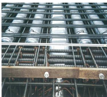
鉄筋コンクリート造梁の斜め貫通孔工法
