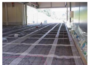
写真-4 土間施工例
