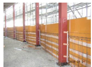
写真-2 壁施工例
