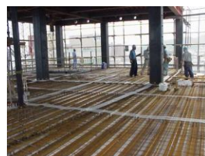
写真-3 スラブ施工例
