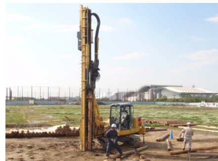
図-2 丸太打設状況
