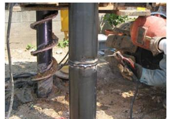
写真-4 補強材の接続
