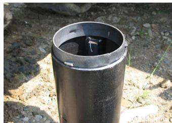
写真-3 継ぎ手治具の取り付け
