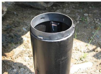
写真-3 継ぎ手治具の取り付け
