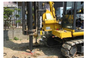
写真-2 施工状況
