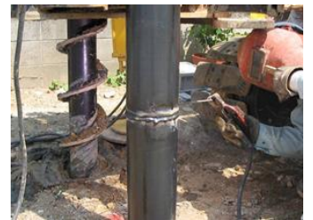
写真-4 補強材の接続
