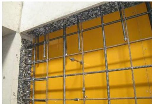
ウォータージェット工法を用いた接合部（内付け補強時）
