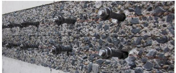
ウォータージェット工法を用いた接合部（外付け補強時）
