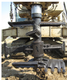
写真-1 SSコラム工法攪拌翼
