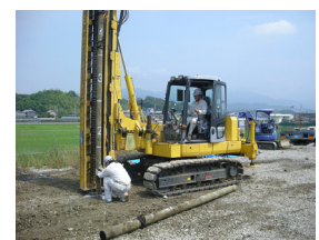
写真-2 施工状況
