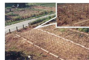
写真-3 耐久性試験状況
