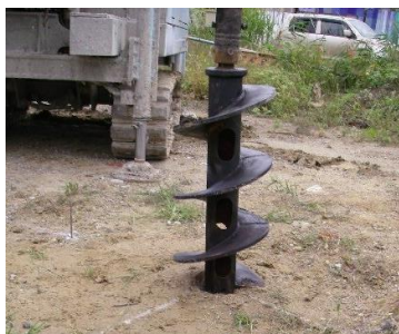
写真-1 オーガー掘削
