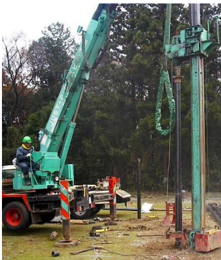
写真-1 施工状況
