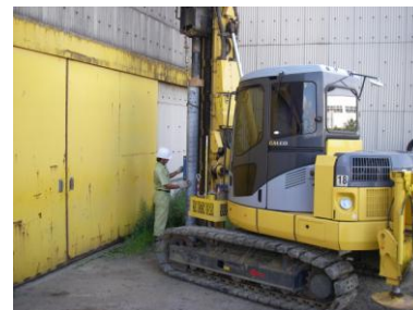
写真-3 構造物に接近した施工
