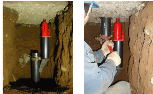
仮設ブラケットでの仮受け
