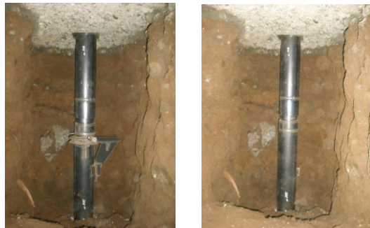
荷重保持用ジャッキ撤去
