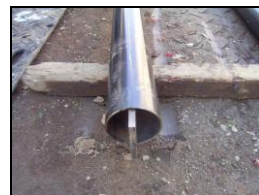
〔ストレート型 杭先端写真〕
