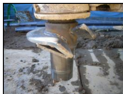
〔 拈底型 杭先端写真 〕
