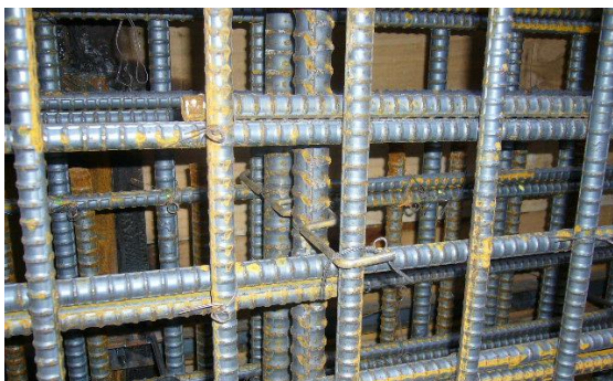
写真-1 ひび割れ誘発材設置状況
