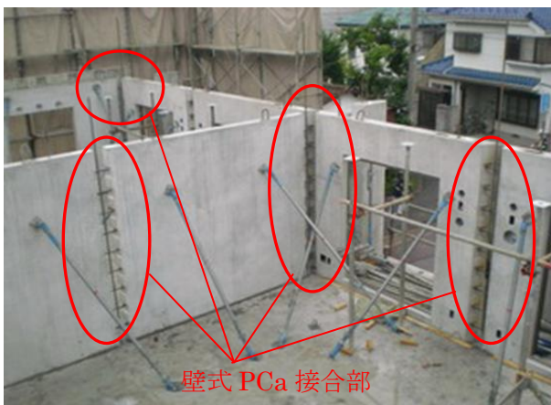
写真-1 PCa 接合部の概要
