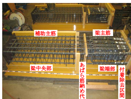
写真 1. 試験体の配筋状況
