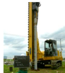
施工状況写真
