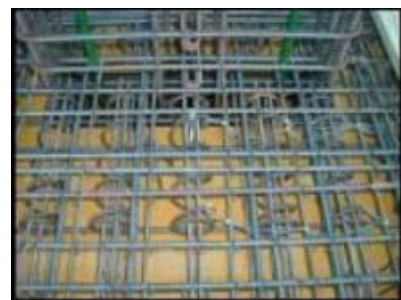
パンチング破壊補強用スパイラル筋の配置状況
